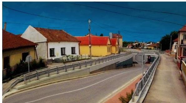
Obrázok 42 Podjazd pod železničnú trať
